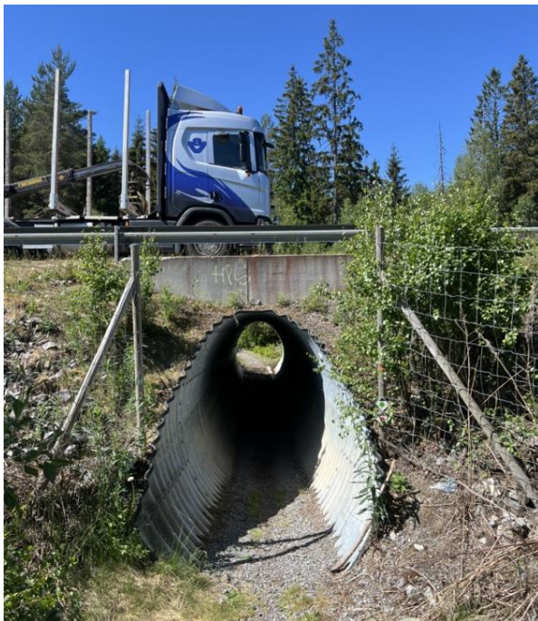
Kulvert som kopplar samman skogsområdena på varje sida av väg 52/55/56
